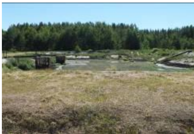
Рисунок 1.6 – Общий вид иловых площадок
