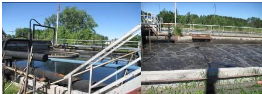
Рисунок 1.5 – Первичный отстойник и аэротенк
