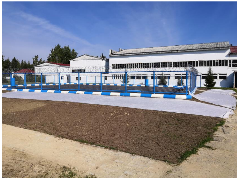
Рисунок 1.5 – Общий вид подземного резервуара питьевой воды
